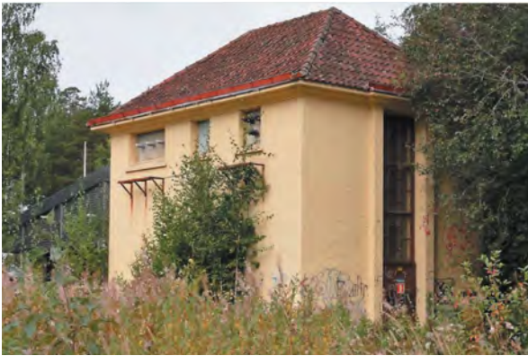
Kuva 20 Mälkiän muuntamo (Kulttuuriympäristökohde 15; kuva Lauri Putkonen).
