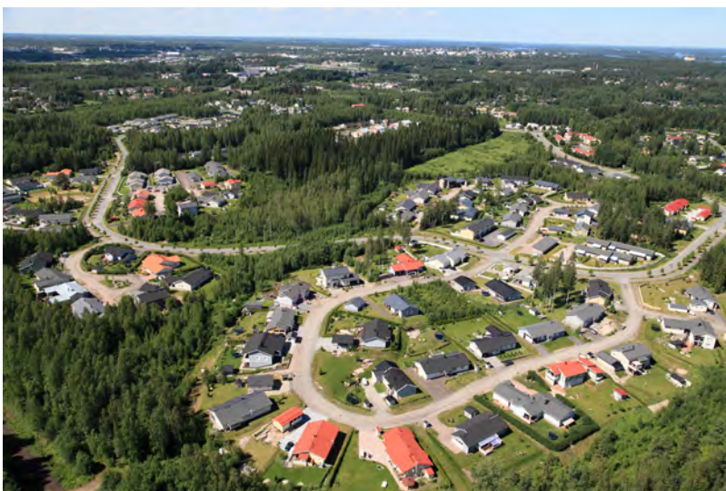
Kuva 8 Karhuvuoren asuinalueetta jösentävät lähimetsät. Kuva: © Lappeenrannan kaupunki, kiinteistö- ja mittaustoimi 2014. Kuvaaja Raimo Suomela.
